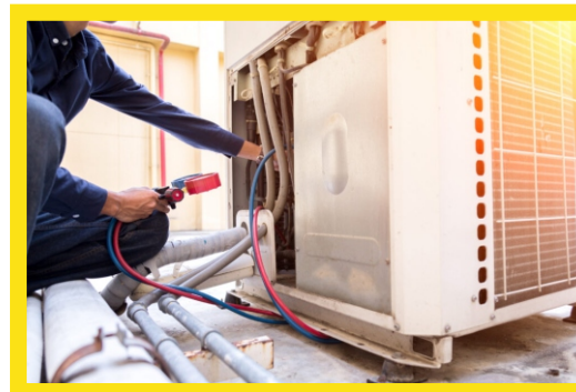
Refrigeración Colocación y Service
