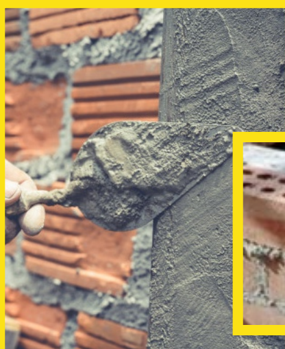
Albañilería en general
